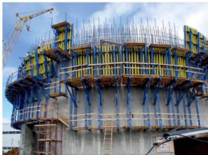
Рис. 19. Пример использования системы подъемно-переставных подмостей в комплекте с радиусной балочно-ригельной опалубкой.
