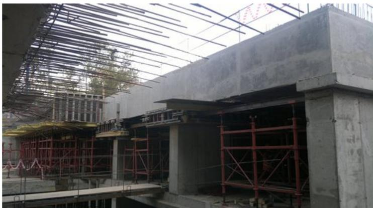
Отдельная задача опалубки переходной плиты - удержание массы бетона, аналогично заливке перекрытий. Здесь в качестве подпорной системы применяются мощные стойки с высокой несущей способностью. Боковое давление бетона ограничивается стандартными линейными щитами с тяжами, приваренными к арматурному каркасу.
